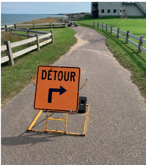
SENTIER BARRÉ À CAUSE DE L'ÉROSION
